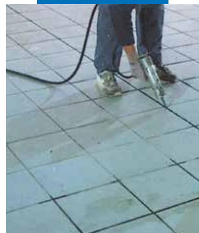
Afdichten van een keramische tegelvloer met Mapesil AC
