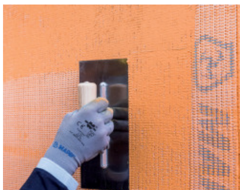
Plaatsen van Mapetherm Net in de natte laag Mapetherm Flex RP
