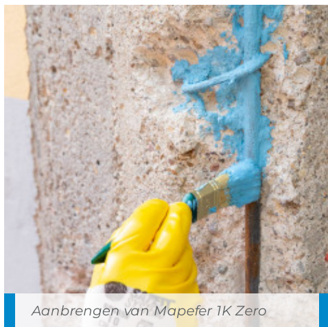
Aanbrengen van Mapefer 1K Zero op de wapening van een viaduct
