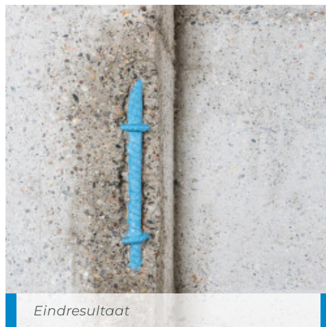
Aanbrengen van Mapefer 1K Zero op de wapening van een viaduct
