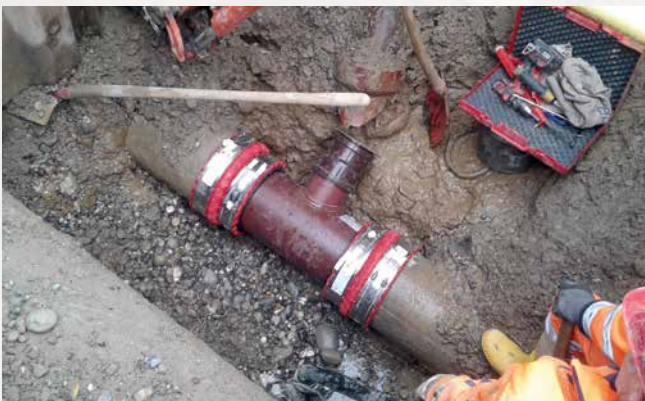
Nachträgliches Einbinden eines Reparaturabzweigs (oben) bzw. Reparaturrohrs (unten) in eine bestehende Steinzeugleitung
