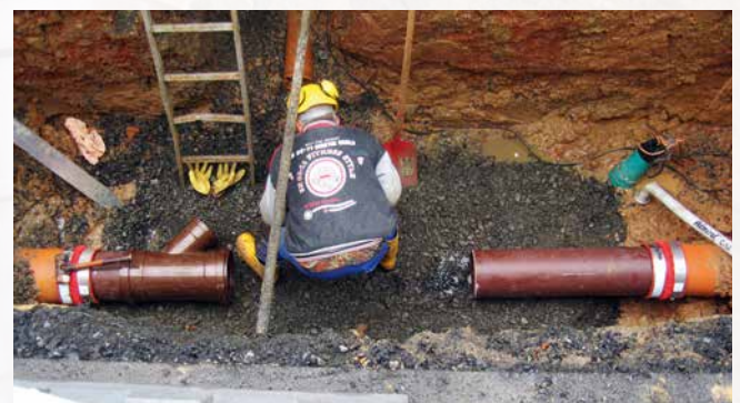
Reparieren von defekten Leitungen
