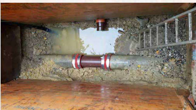
Nachträgliches Einbinden eines Reparaturabzweigs (oben) bzw. Reparaturrohrs (unten) in eine bestehende Steinzeugleitung
