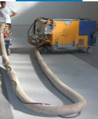
Vorbereiden van de ondergrond door gritstralen
