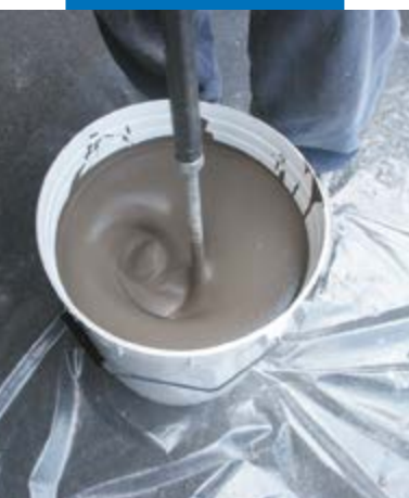
Bereiding van het product met een boormachine
