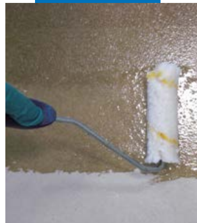
"Venetiaans Terrazzo" effect. Aanbrengen van Mapefloor I 910
