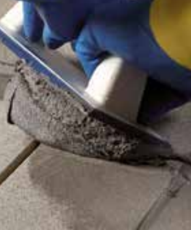
Aanbrengen van Kerapoxy CQ met een MAPEI-spaan
