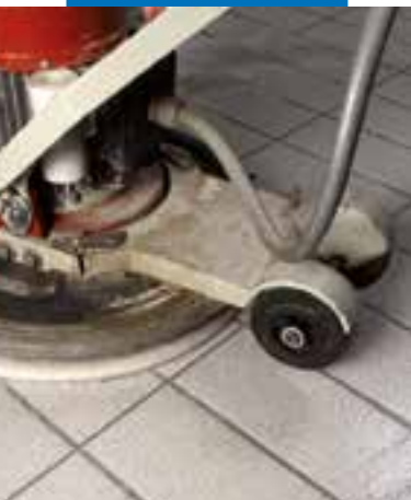
Reiniging met water met behulp van een inwas- en uitpoetsmachine met vilt-schuurschijven van het type Scotch-Brite®
