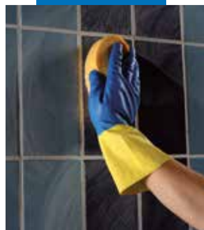
Reiniging en afwerking met een harde cellulose spons
