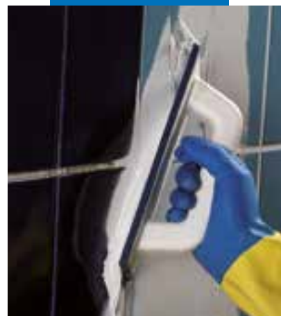
Op de wand aanbrengen van Kerapoxy CQ met een MAPEI-spaan
