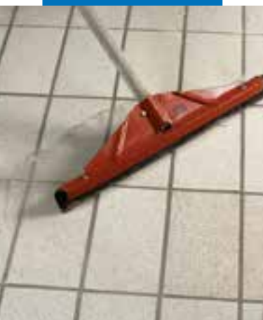
Verwijderen van het vloeibare restant met een rubberen vloertrekker
