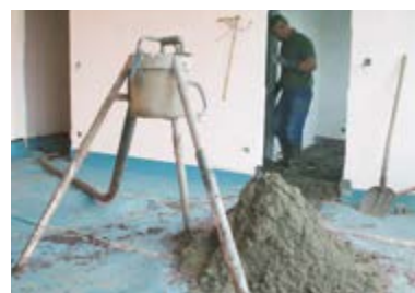
(4) Een chape uitvoeren van min. 5 cm dikte op de 4+2
